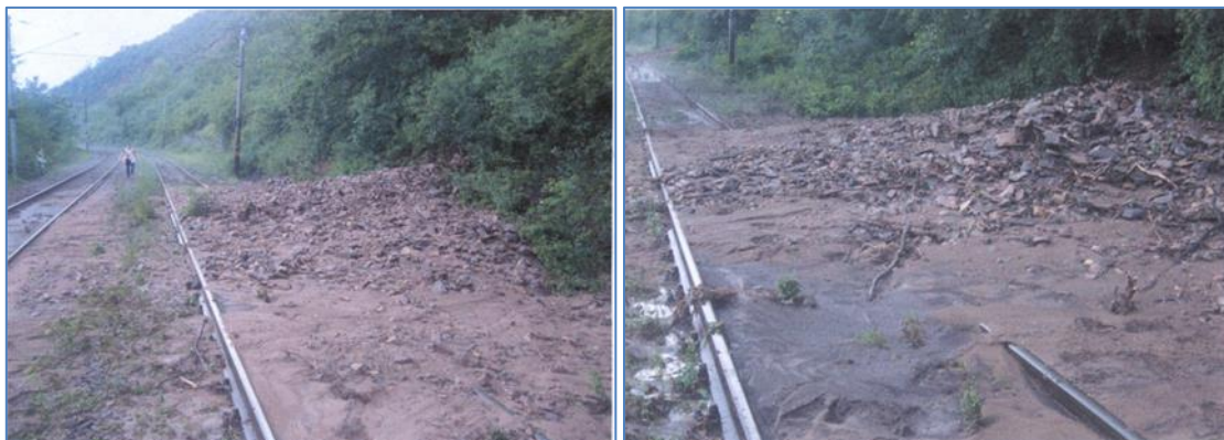
Obr. 13. Zbahnění kolejového lože 2. traťové koleje
