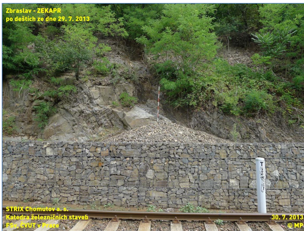
Obr. 7. Příklad suťového kuželíku vzniklý důsledkem ZEKAPR
