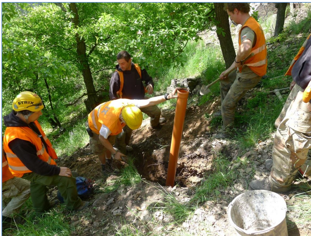
Obr. 29. Pohled na osazování PVC pažnice v kopané sondě
