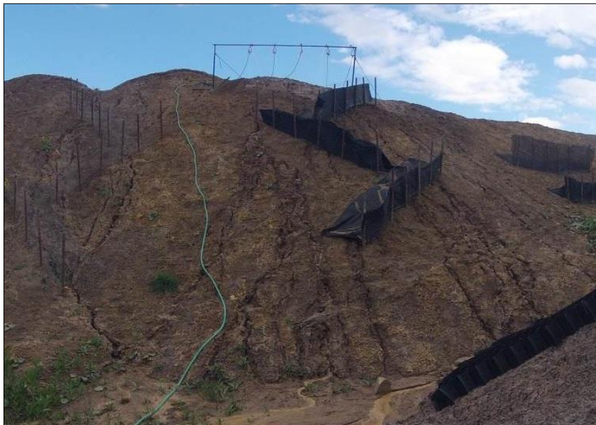
Obr. 61. Erozní rýhy způsobené dešťovým simulátorem
