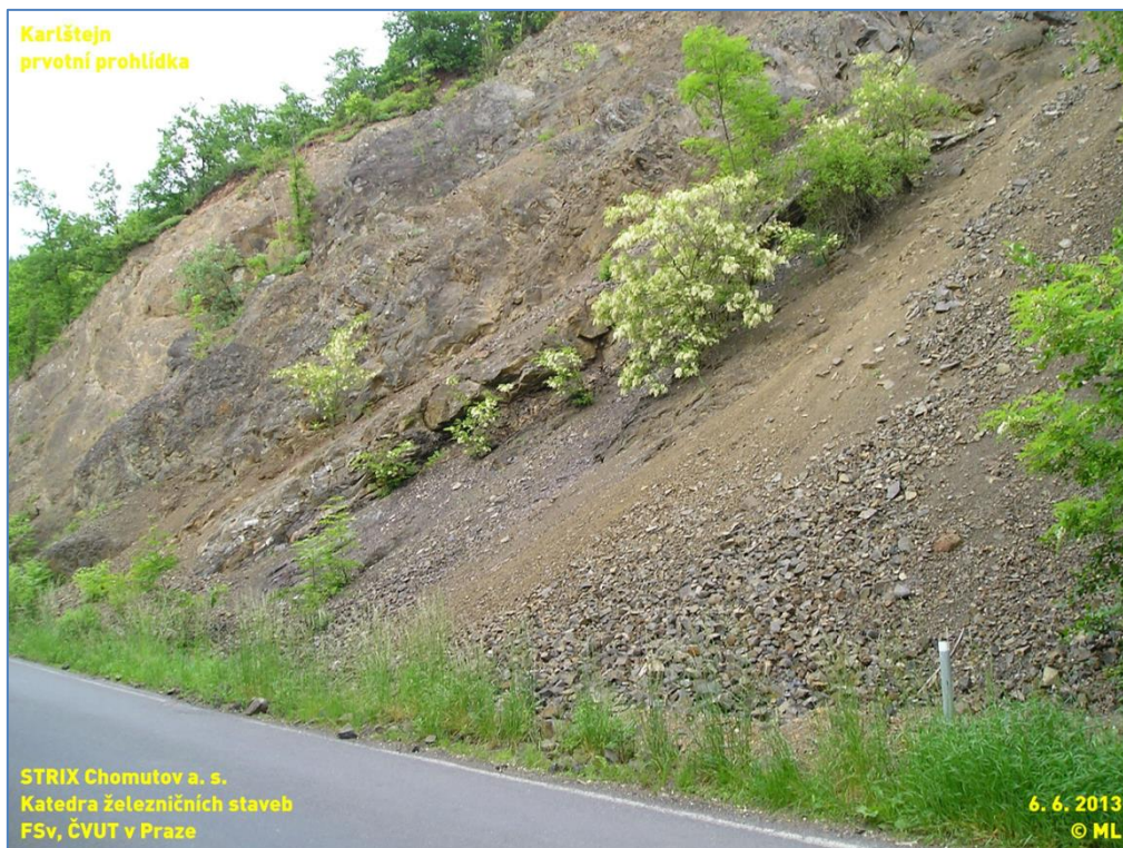
Obr. 10. Suťové pole na strmém svahu
